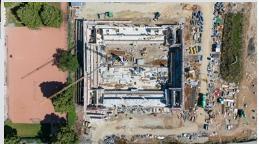
08/2023 – Fertigstellung bis zur zweiten Geschossebene
