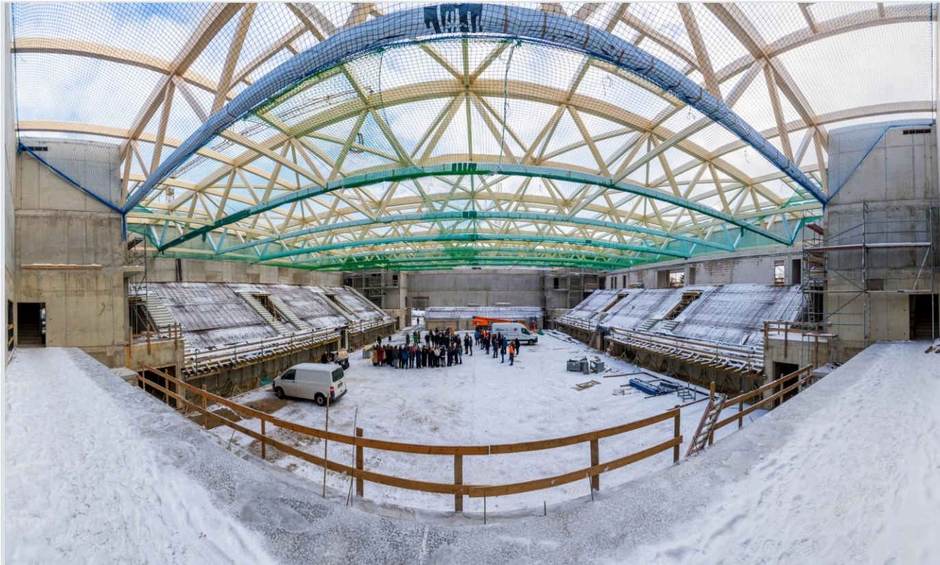
06.12.2023 Richtfest – Fertigstellung Dachkonstruktion
