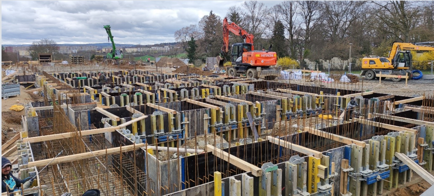
Beginn der Rohbauarbeiten (Grundsteinlegung am 08.05.2023)
