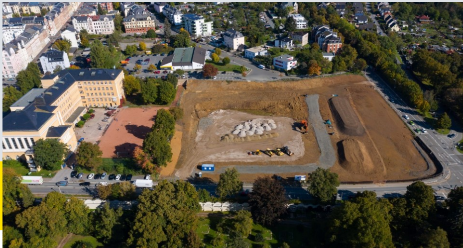
Mai 2023 – Beginn der Geländeregulierung und Entwässerungsarbeiten (Spatenstich am 06.05.2022)
