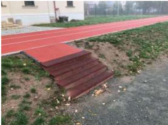
Zugangsbereich, Stufenanlage ohne Handlauf
