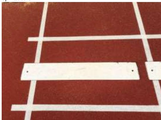
Absprungbalken etwas zu tief – Stolpergefahr, Lage unsachgemäß
