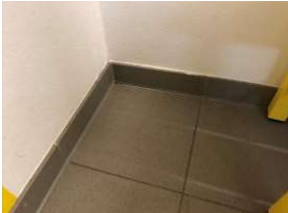
Abreißen der Fugen im Wand-Fußboden-Anschluss
